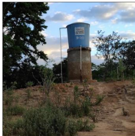
Figura 2 - Reservatório de água salobra
