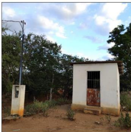
Figura 1 - Poço de Água Salobra - UTM 212263.07 E 8796546.94 S
