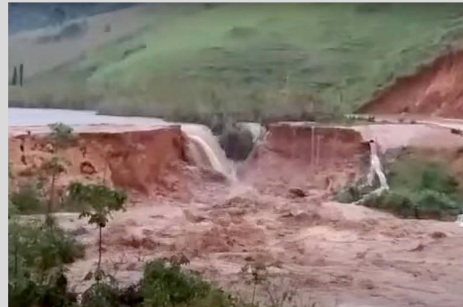
Rompimento de barragens em Apuarema/BA - 2021
