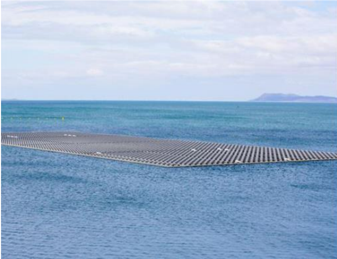
Plataforma Solar Flutuante no Reservatório de Sobradinho (BA) 1 MW - 1,1 ha
