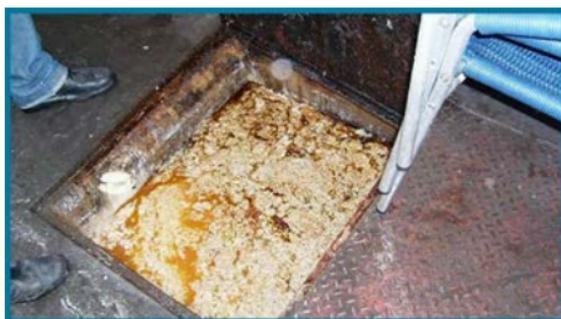
Foto 8.1 – Caixa de gordura necessitando de limpeza
