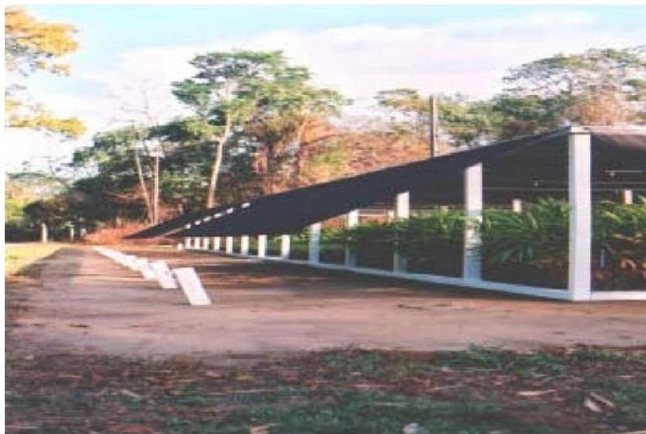
**Figura 6.10 - Vista lateral de viveiro com esticador nas laterais**
