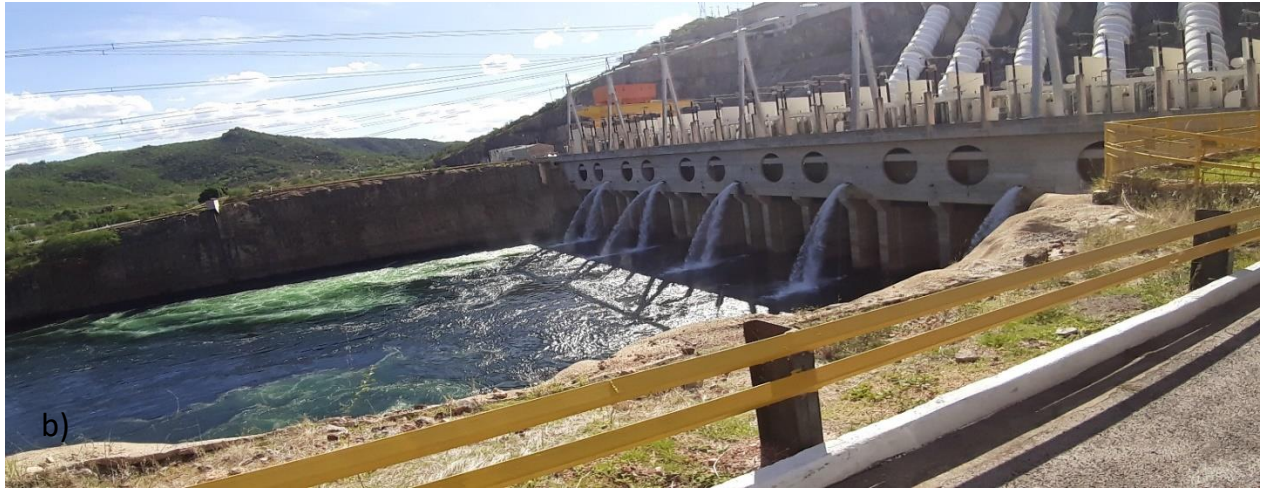
Figura 2. Usina hidroelétrica de Xingó, Rio São Francisco (a, b). Fotos Cavali, 2019
