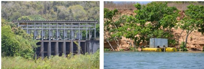
Figura 8. Bombas de retirada de água para a irrigação. Foto: Vanildo S. Oliveira
