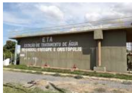
Equipe Saneamento 02: visita à Estação de Tratamento de Água
