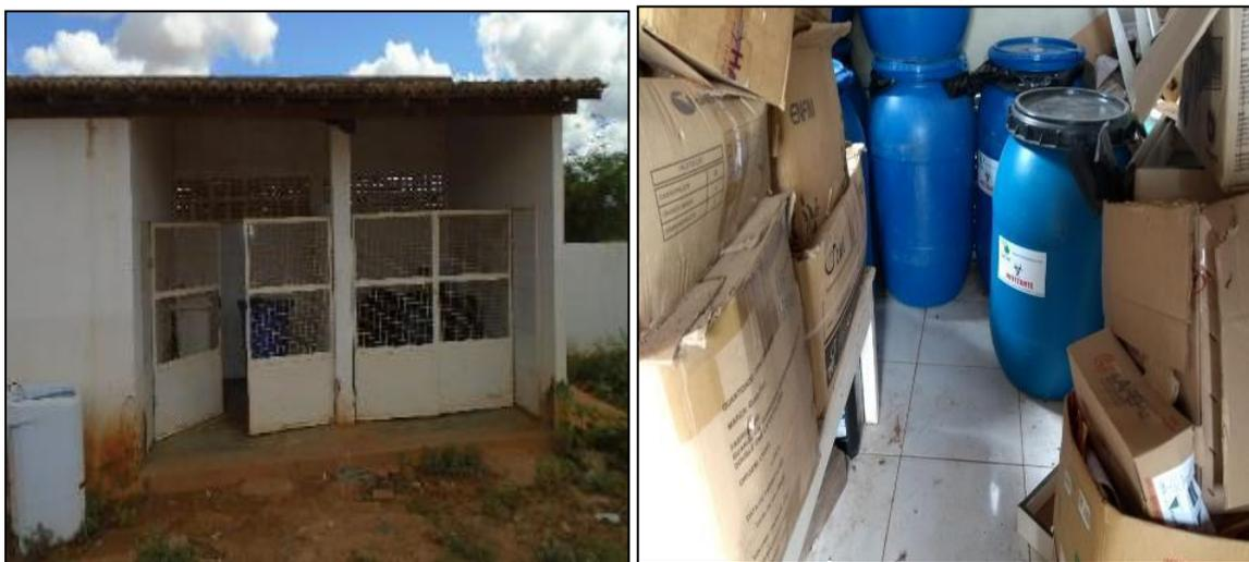
*Figuras 09 e 10 - Vista do abrigo externo de RSS. Nota -se ausência da devida identificação preconizada na ABNT NBR 7500 e abertura de ventilação sem devida proteção no Município de Ourorândia, Ba (esquerda). RSS dispostos com outros itens na Unidade de S.*
