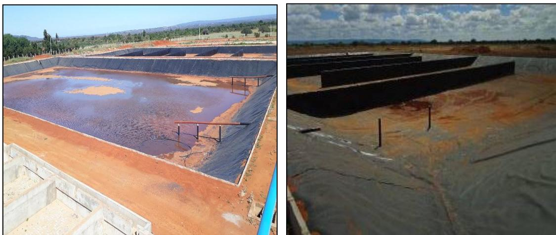
*Figuras 03 e 04 - Obras de implantação do SES em Umburanas-BA (à esquerda) e em Ourolândia-BA (à direita).*
