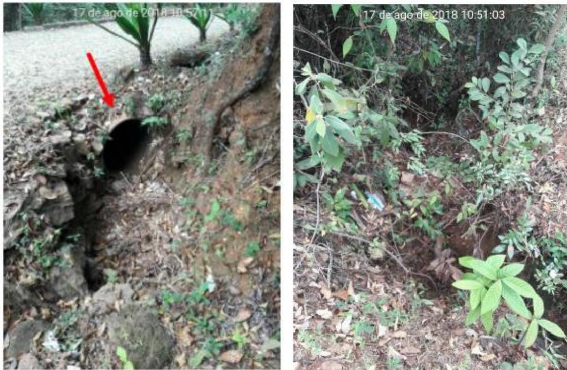
Figura 25 - Erosão linear em Macacos, com destaque para a manilha de drenagem de água pluvial. FONTE: Projeta Engenharia, 2018.
