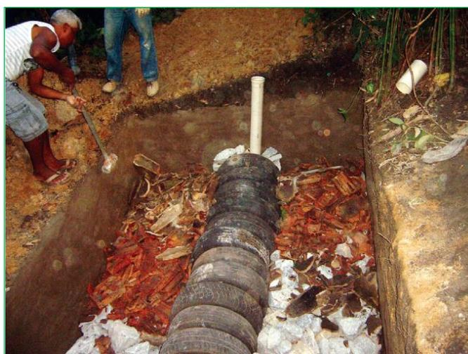
**Figura 25 – BET – Tubo de entrada na câmara e enchimento da trincheira com entulho.**
