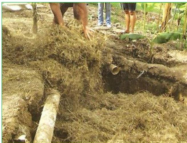
**Figura 33 – Preenchimento da vala com palha seca.**
