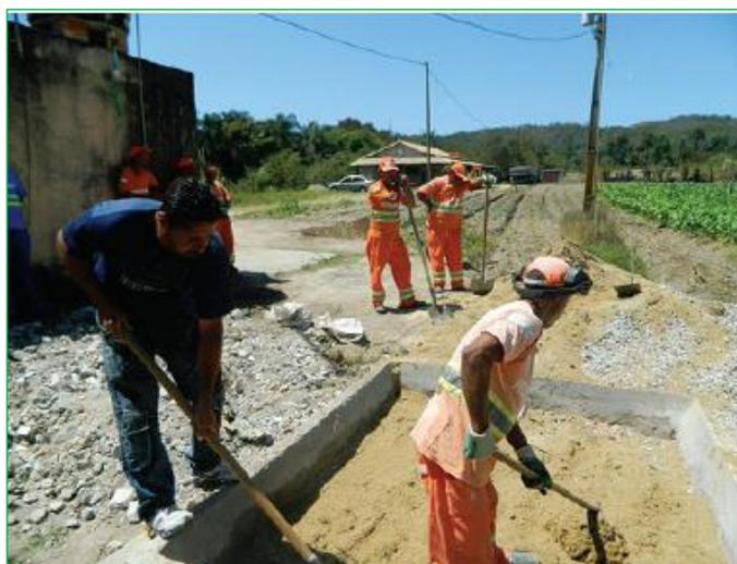
**Figura 26 – BET - Enchimento da trincheira com camada de areia.**
