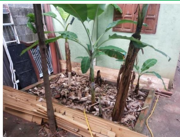
**Figura 28 – BET em funcionamento com plantio de caninha-de-macaco e com plantio de bananeiras e tubo de inspeção, em Santana do Riacho / MG.**
