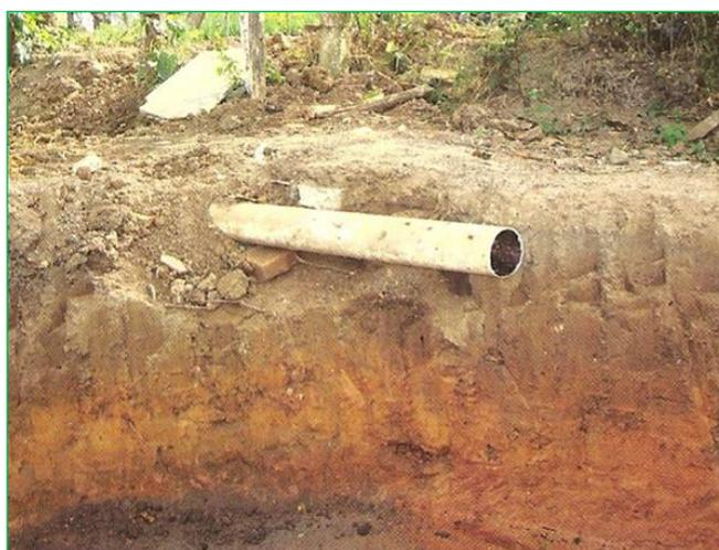
**Figura 32 – Vala escavada e tubo de lançamento das águas cinzas.**
