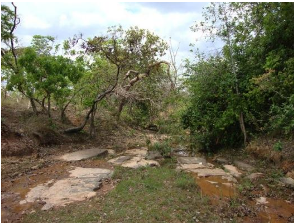
Foto 4. Outro trecho do Córrego Trinchete com pouca água empossada e com a mata ciliar degradada.
