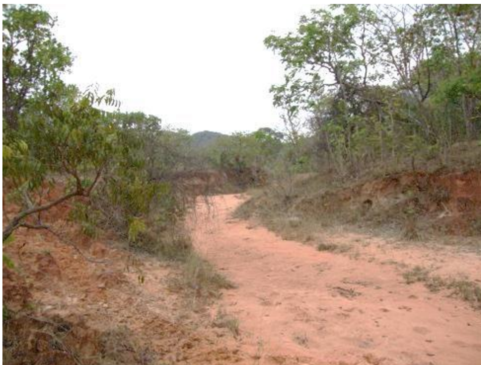
Foto 1: Antiga estrada transformada em voçoroca carreando sedimentos
