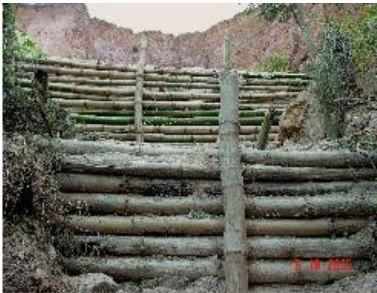
Foto 7: Exemplo de paliçada construída com bambu
