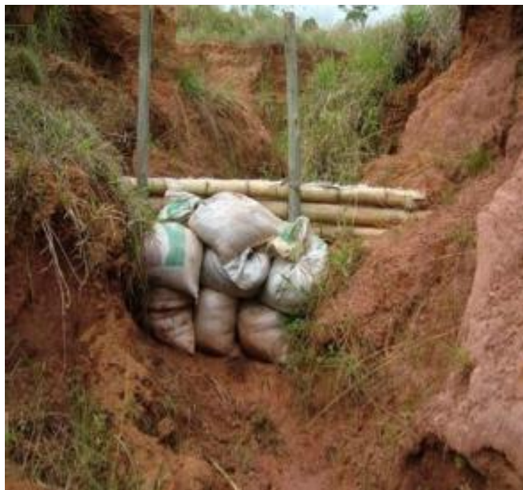
Foto 6: Representação de uma paliçada feita de bambú e sacos com terra servindo escora
