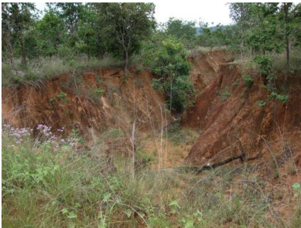
Foto 3: Voçoroca causada pela enxurrada proveniente da estrada a montante
