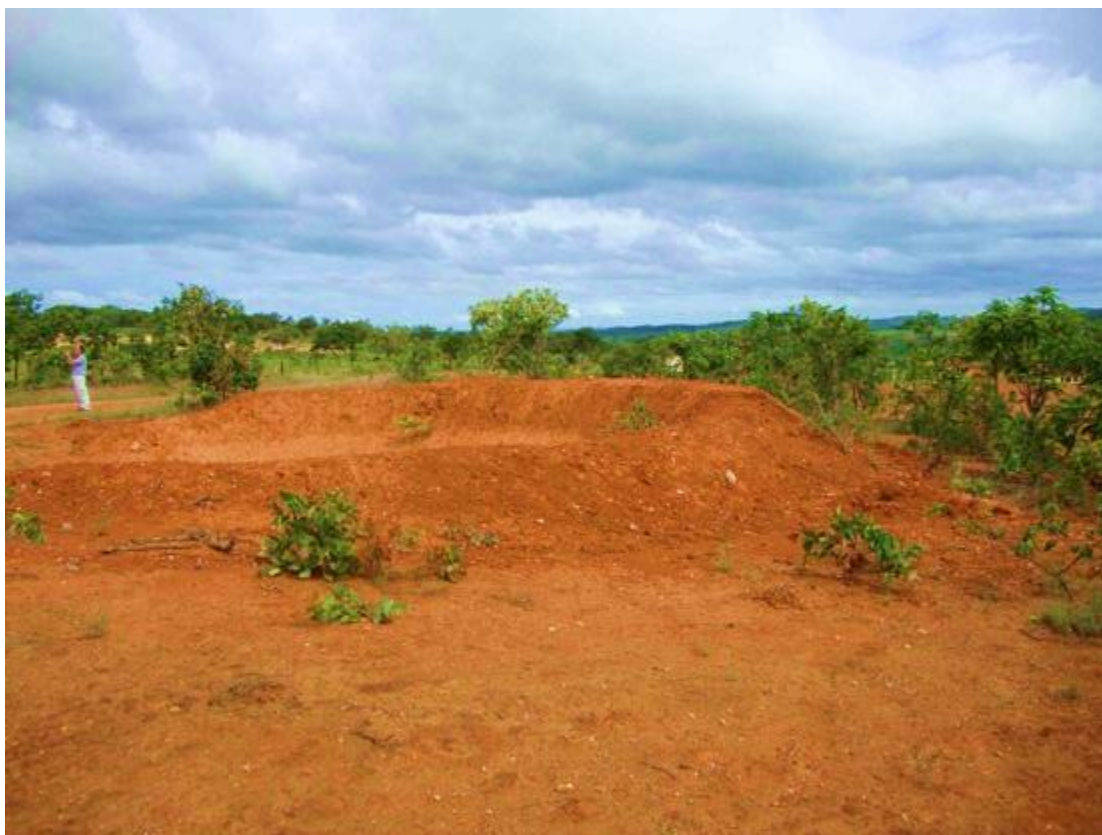
Foto 9: Vista lateral da mesma barragem da foto acima.
