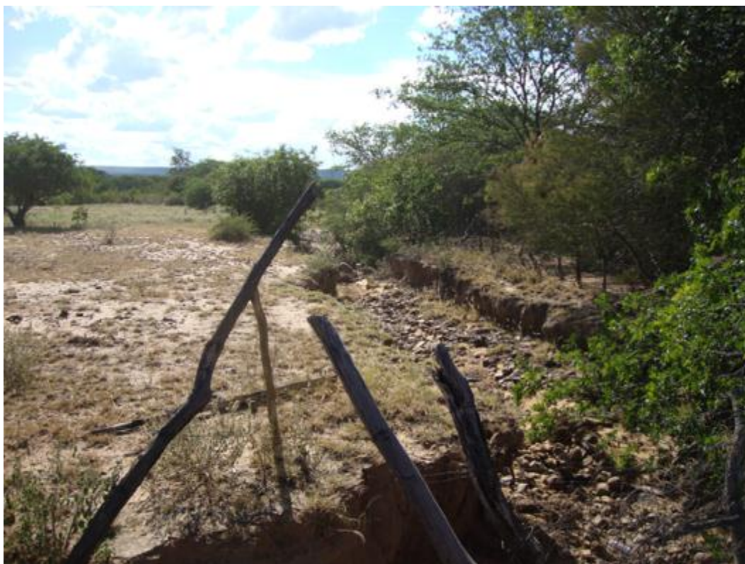
Foto 6: Erosão causada por estrada e por área de plantio com solo exposto e sem medidas de conservação do solo.
