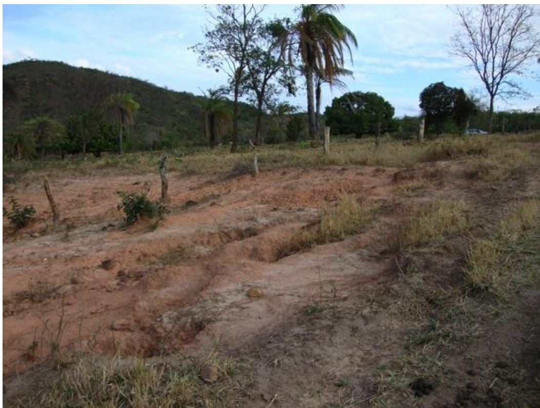
Foto 3: Processo de ravinamento, ou erosão superficial, visto de outro ângulo.
