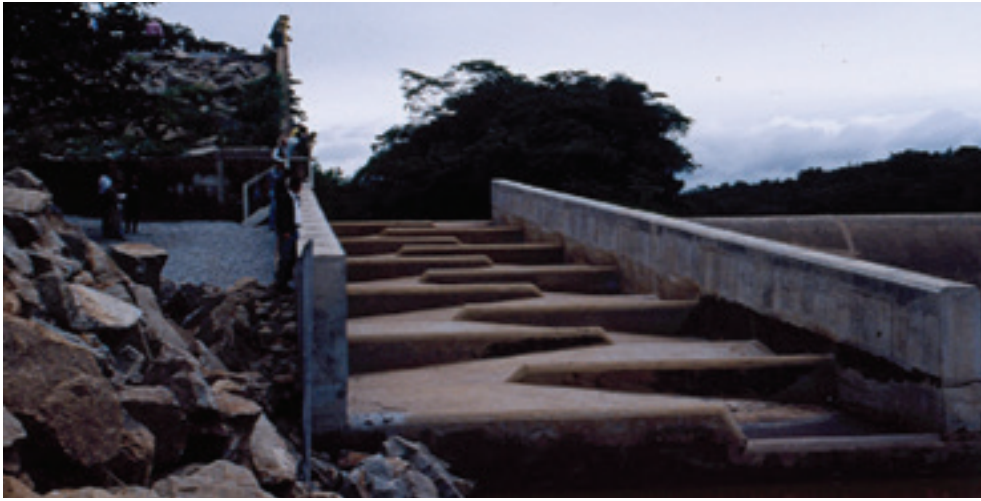
FIGURA 1 – Concepção do projeto da escada experimental, antes do início de sua operação em novembro de 1994. Foto: CBMAIves.
