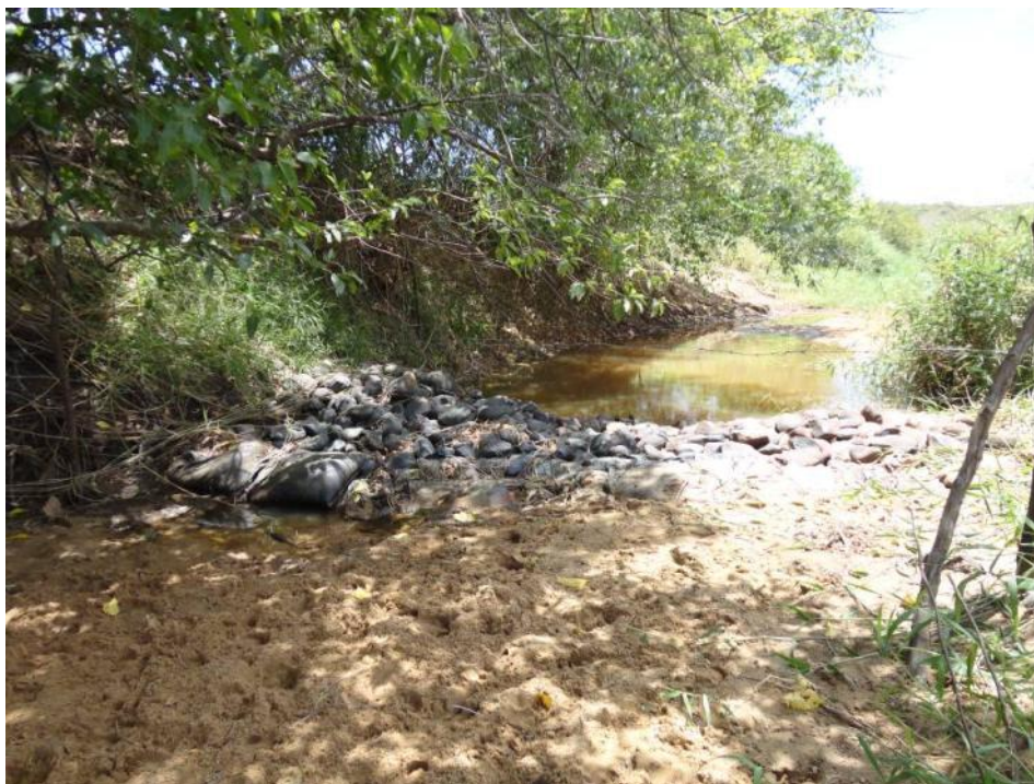
Fotografia 3 - Diques construídos de sacos de areia e seixos mostrando retenção de sedimento a montante e surgência de água a jusante.
