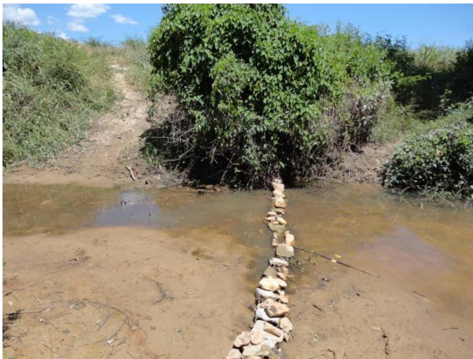
Fotografia 2 – Detalhe das barreiras de pedras para retenção de água no leito do rio.
