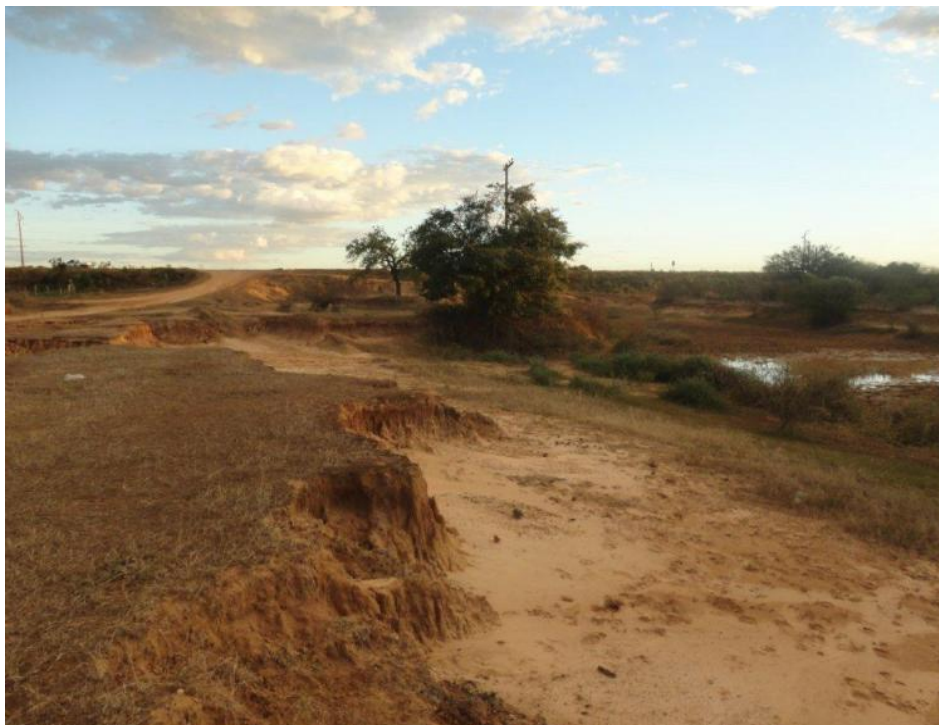
Fotografia 8 – Trecho inicial da estrada numa antiga jazida de material cascalhoso onde está indicado terraceamento – ao fundo está a BA-349.
