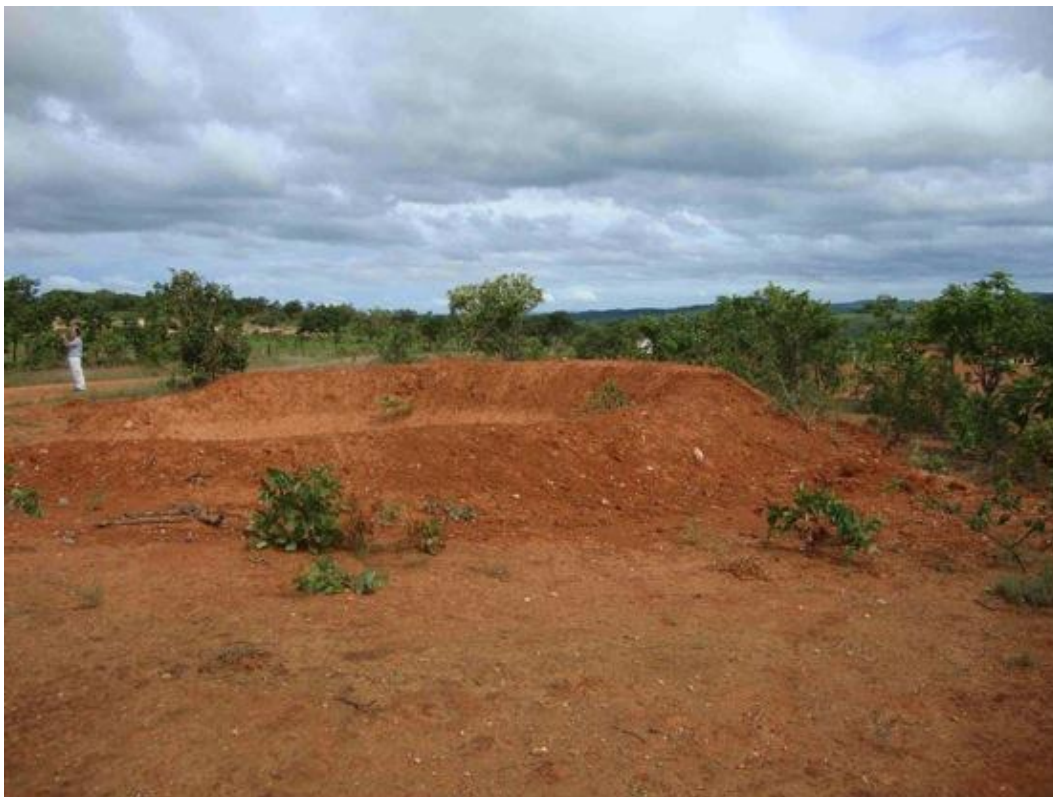
Figura 26 - Vista lateral da mesma barragem da foto acima.
