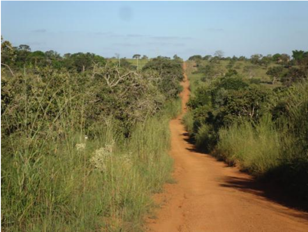
Figura 3: Estrada em área com declividade acentuada sem medidas de controle de águas pluviais.
