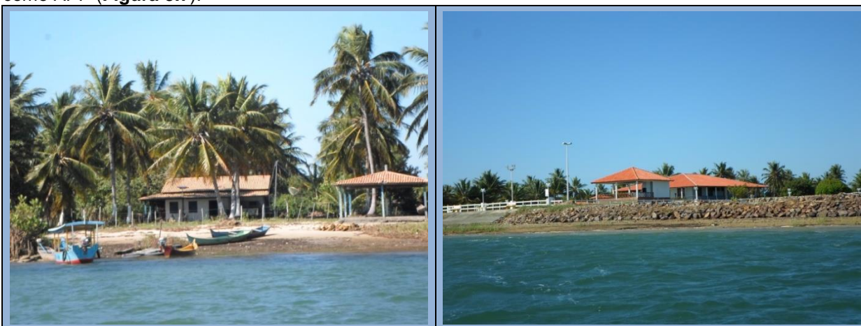
Figura 3.7 - Casas construídas à margem do rio São Francisco.
