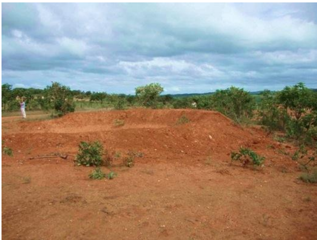
Foto 2: Vista lateral da mesma barragem da foto acima
