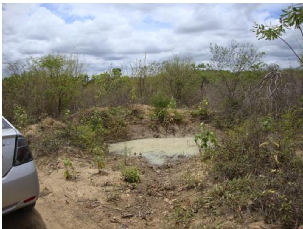
Foto 8: Barraginha construída sem as dimensões correta em área à montante da nascente principal do rio Pajeú.
