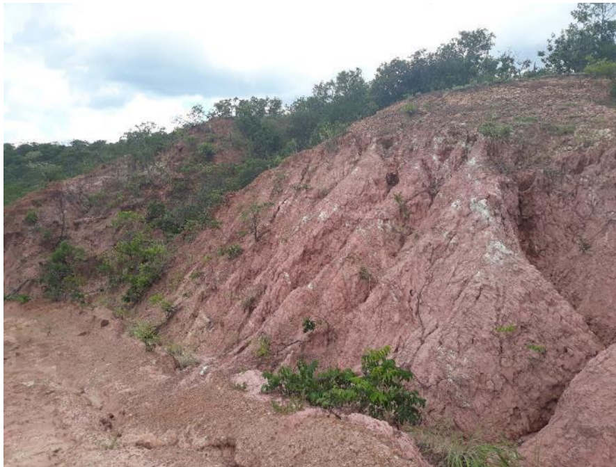
Figura 17- Talude com solo exposto na propriedade do Sr. Miltao.
