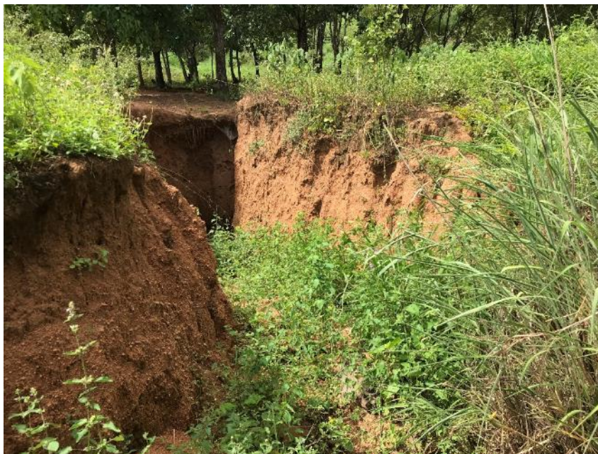
Figura 15- Voçoroca na propriedade do Sr. Alair.
