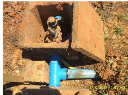
Figura 5 - detalhe da caixa de concreto, com vista de uma estrutura de rede existente no viveiro.
