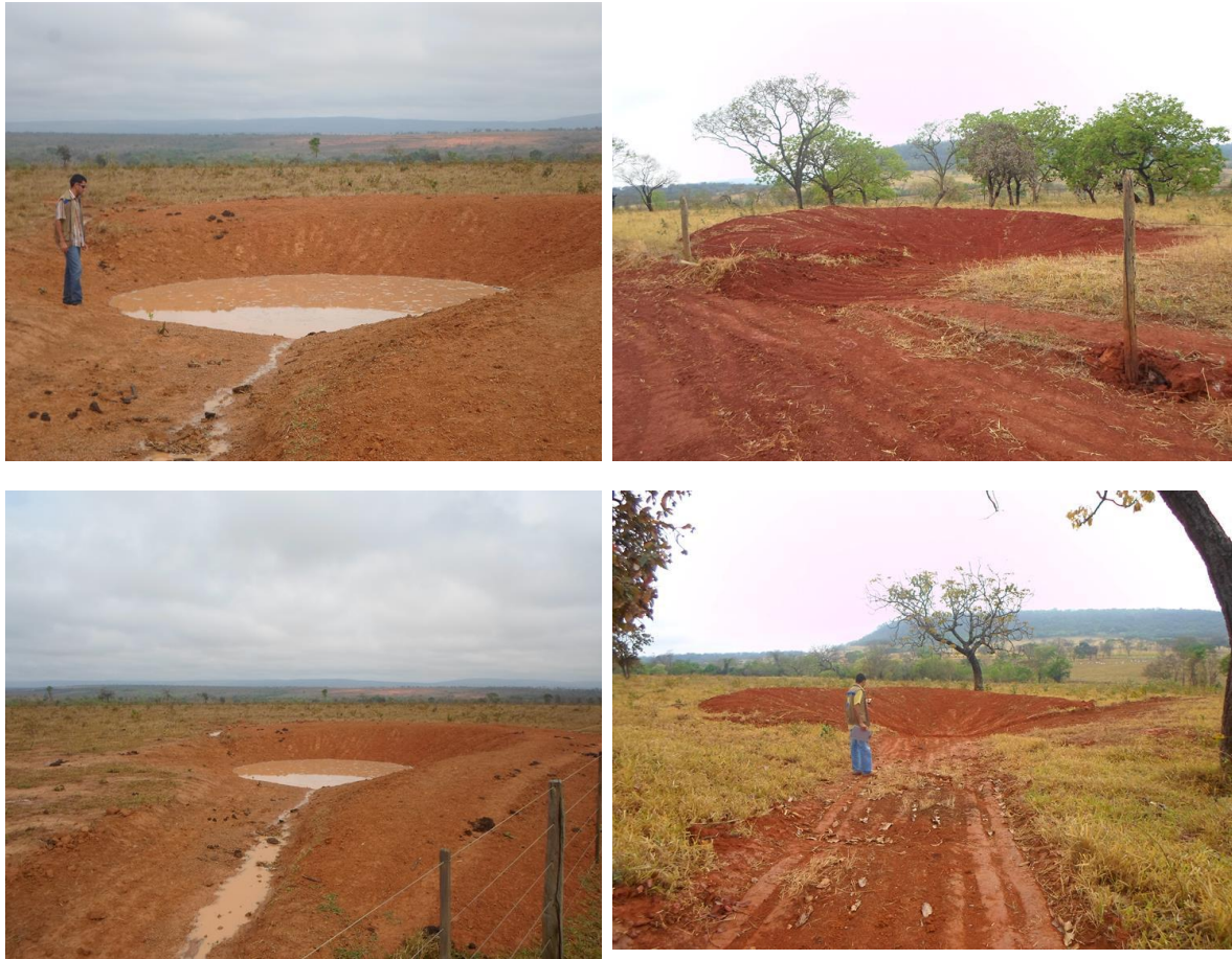
Figura 10: Bacias de captação para coleta de enxurrada gerada em estrada rural
