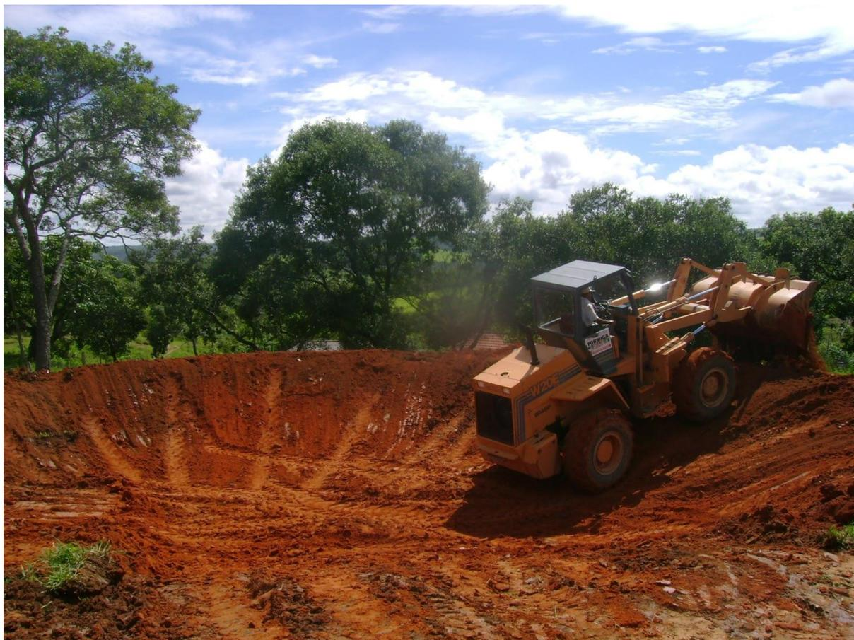
Figura 17: Pá-carregadeira durante a construção de uma bacia de captação
