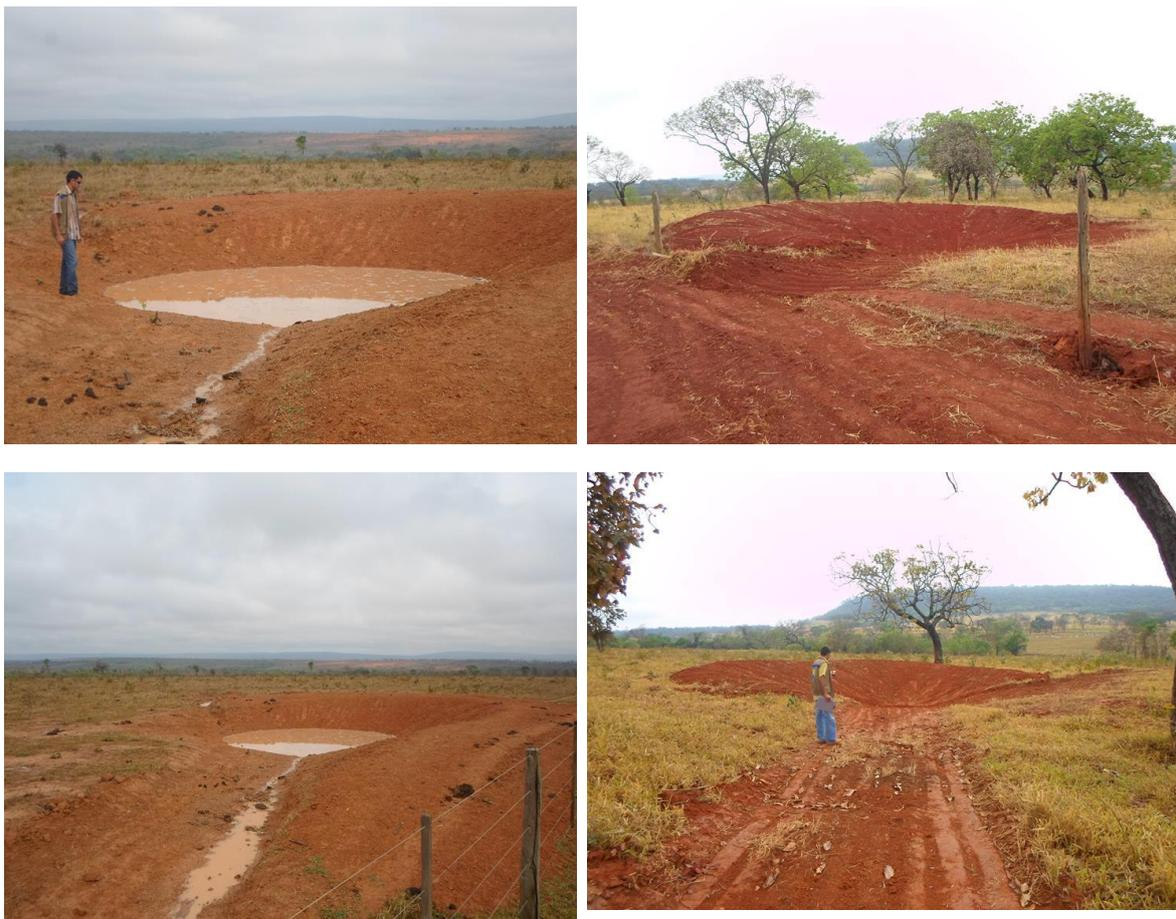
Figura 16: Bacias de captação para coleta de enxurrada gerada em estrada rural
