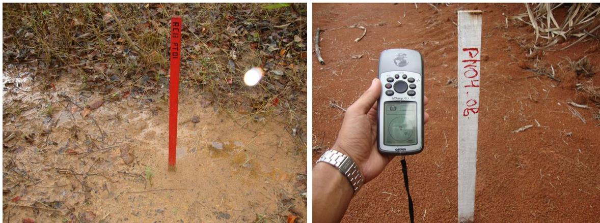
Figura 14: Exemplos de estaqueamentos provenientes de locação topográfica de projetos hidroambientais
