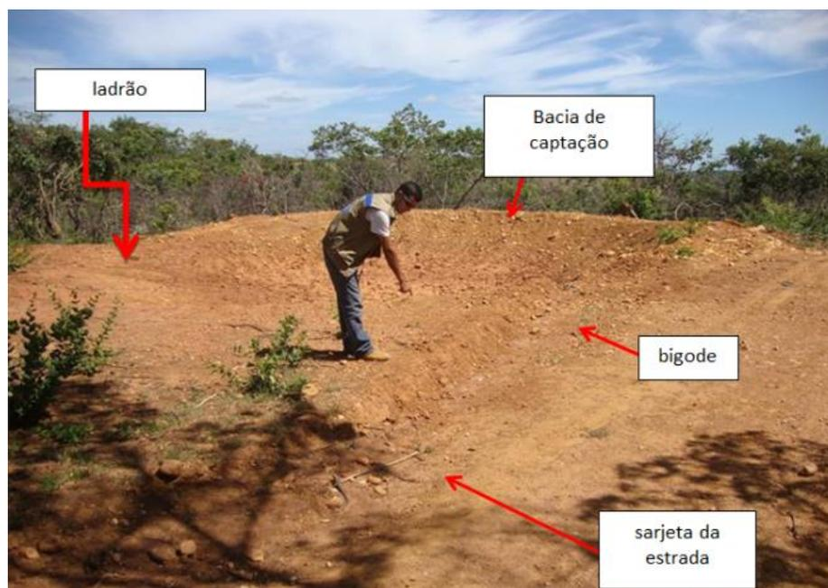
Figura 18: Bacias de captação para coleta de enxurrada gerada em estrada rural
