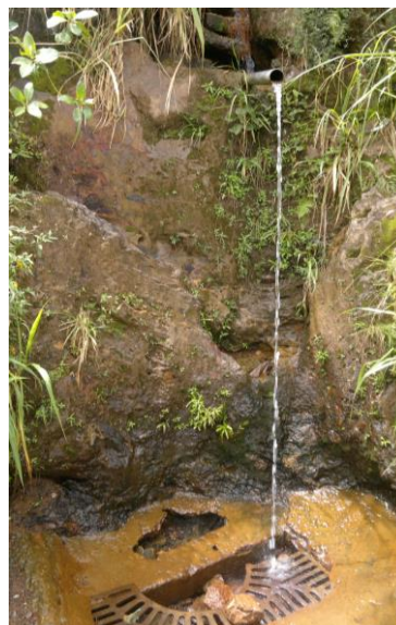
Figura 6.11 – Detalhe da nascente AR-120 canalizada
