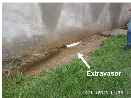
Figura 6.18 – Dreno localizado a jusante do Lago 1
