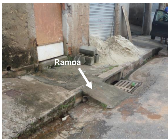
Figura 6.20 – Rampa de concreto a ser demolida
