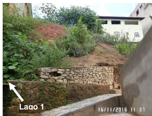
Figura 6.19 – Ocorrência de erosão à montante do Lago 1
