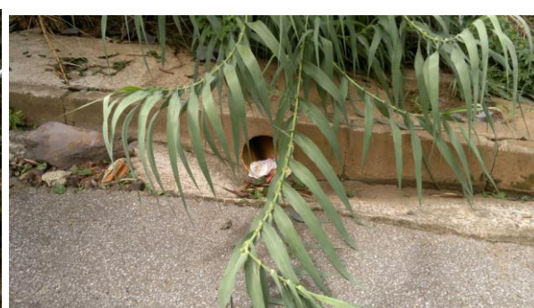
Figura 6.12 – Grade existente na propriedade e saída da drenagem para a sarjeta
