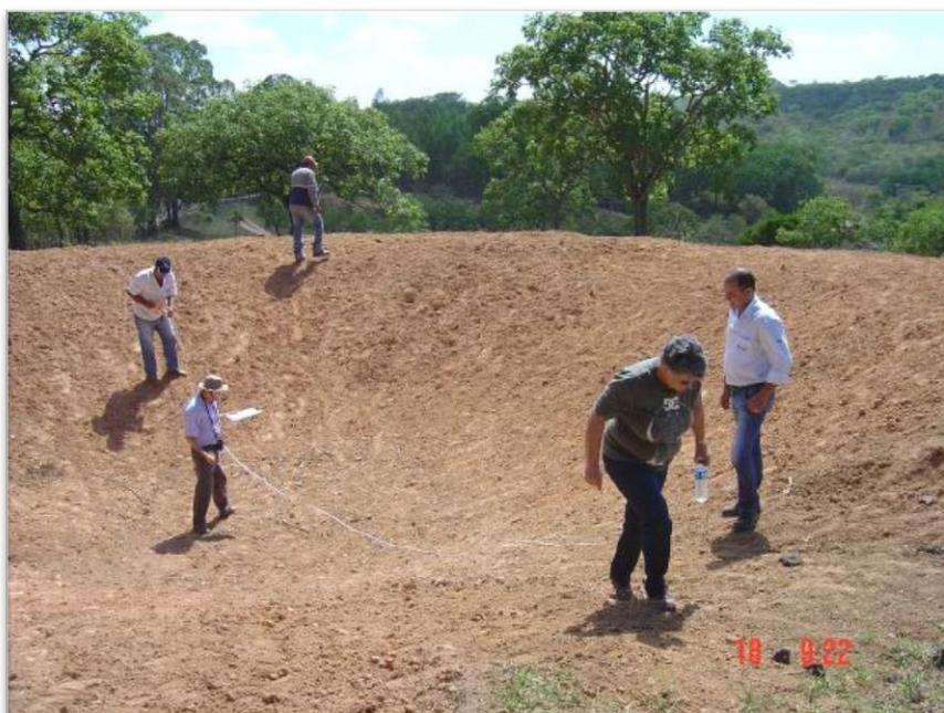
Figura 27 – Engenheiro de Fiscalização realizando medição em bacia de captação pluvial em projeto hidroambiental, Carmo da Mata-MG, no Alto São Francisco. (Fonte: IRRIPLAN, 2014)
