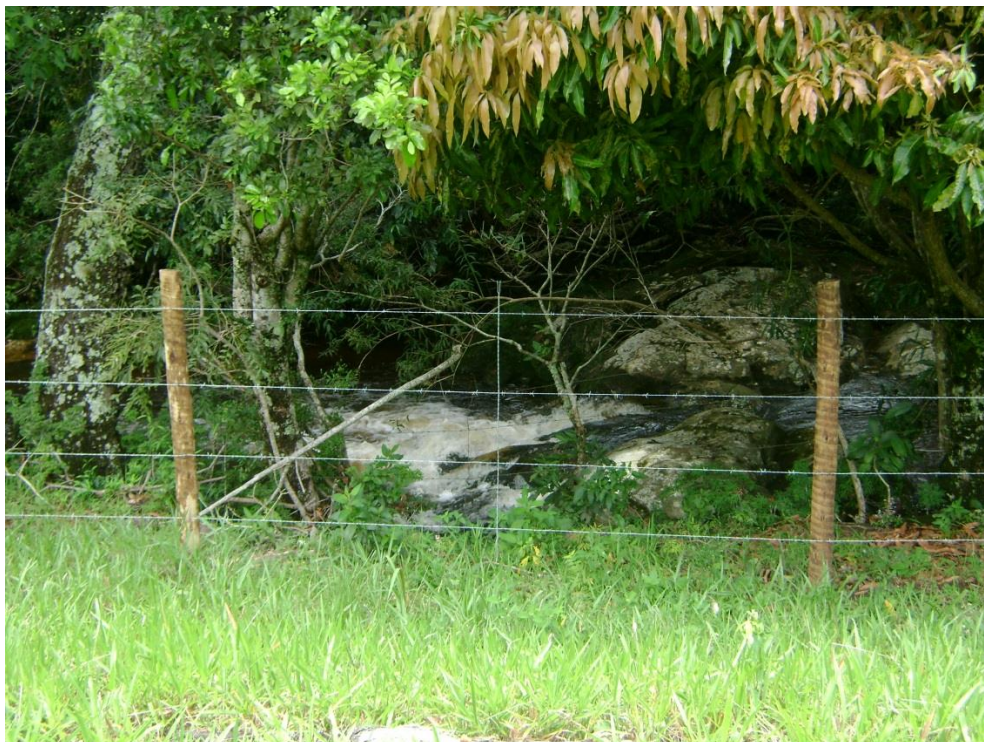
Figura 8 - Execução de cerca para proteção de mata ciliar às margens do Rio Preto, em Nova União. FONTE: AGB Peixe Vivo, 2013.
