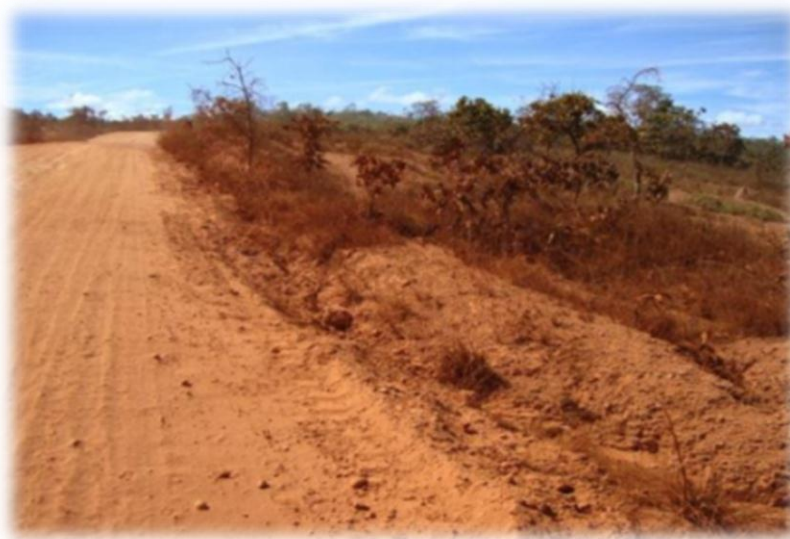
Figura 22: Estrada vicinal sem contenção de águas pluviais à montante da Represa de Três Marias, no município de Morada Nova de Minas, MG.
