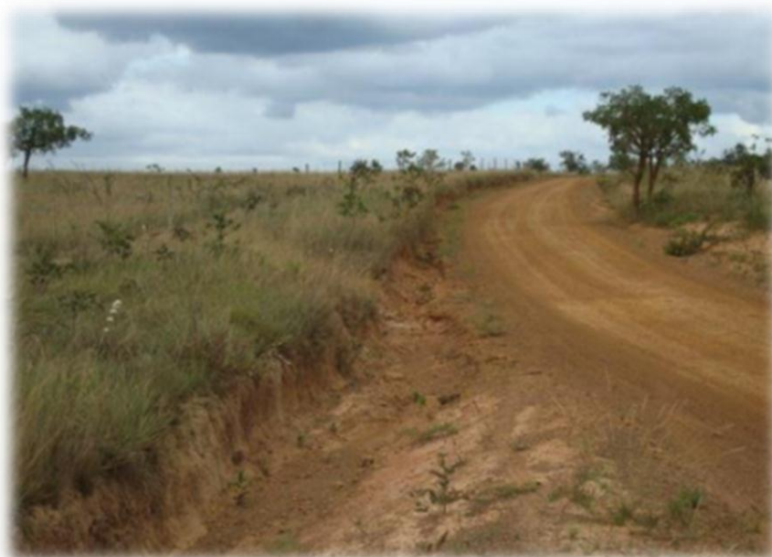
Figura 21: Ocorrência de erosão causada pela enxurrada em estrada vicinal, Pompéu, MG.
