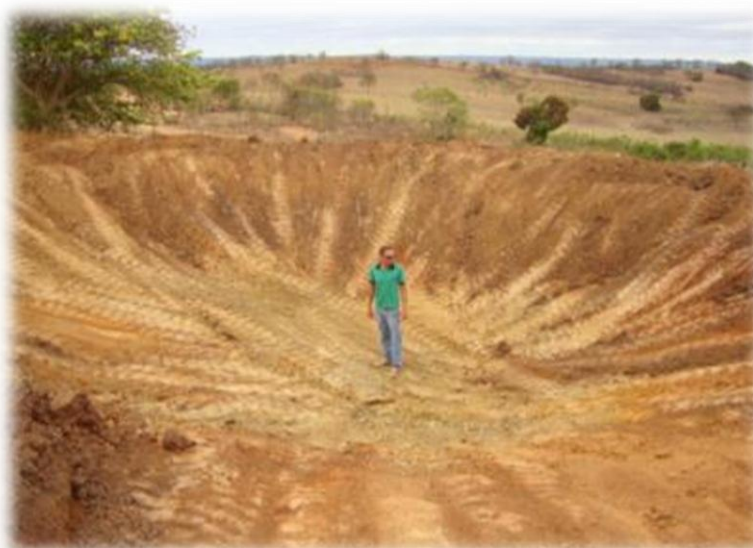
Figura 14: Barragem de contenção de águas pluviais (barraginha) construída em área pertencente à Bacia do Córrego Buritis, Guaraciama, MG.
