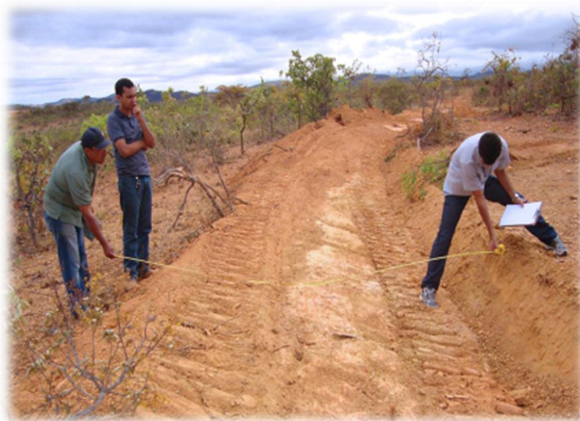
Figura 8: Medição de área de terraceamento, Guaraciama - MG. Fonte: GAMA Engenharia / AGB Peixe Vivo, 2012.
