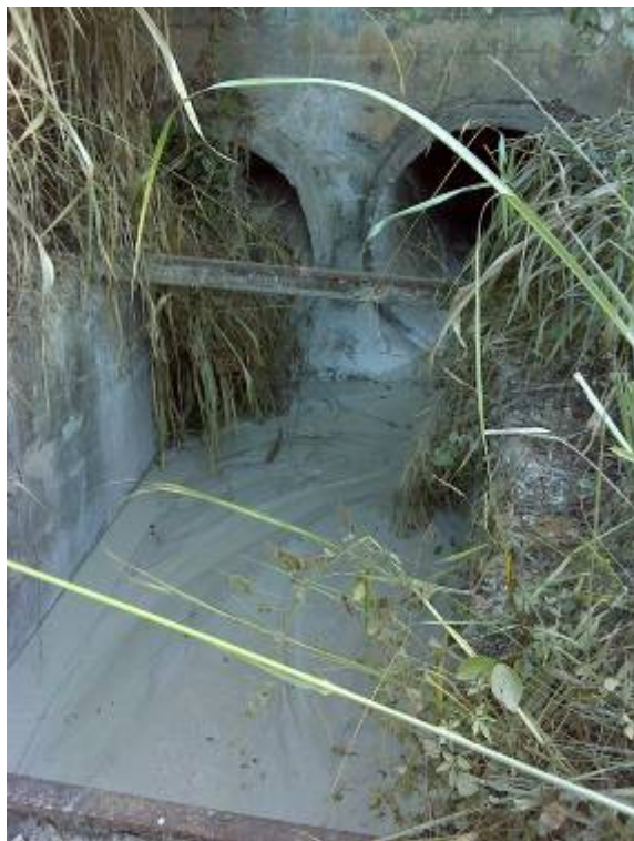
Foto 11: Efluente saindo da empresa cimenteira.
