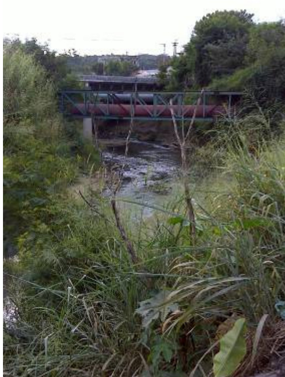
Imagem 5: Ribeirão Isidoro. Esgoto e ocupação irregular.
