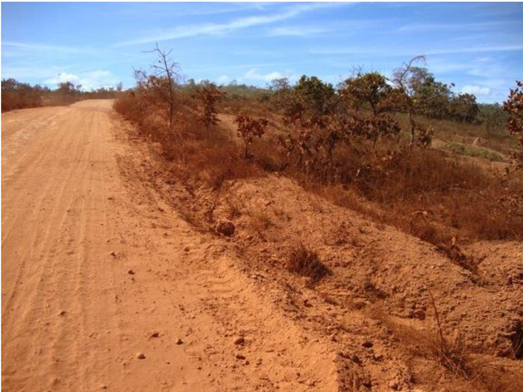
**Foto 2: Estrada sem medidas de controle e contenção das águas pluviais e com processos erosivos instalados.**
