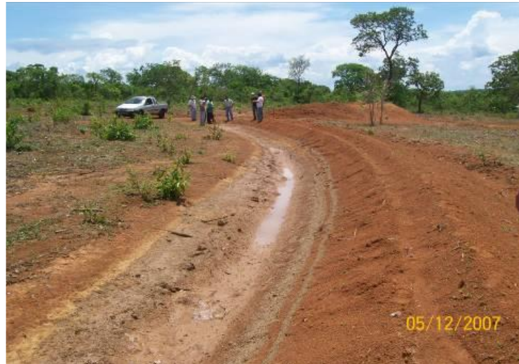
Figura 14: Exemplo de terraço executado
