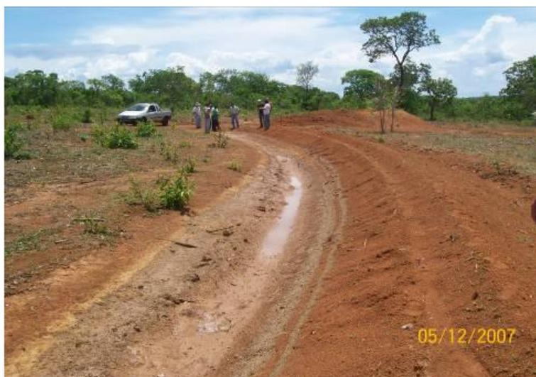
**Figura 14:** Exemplo de terraço executado
