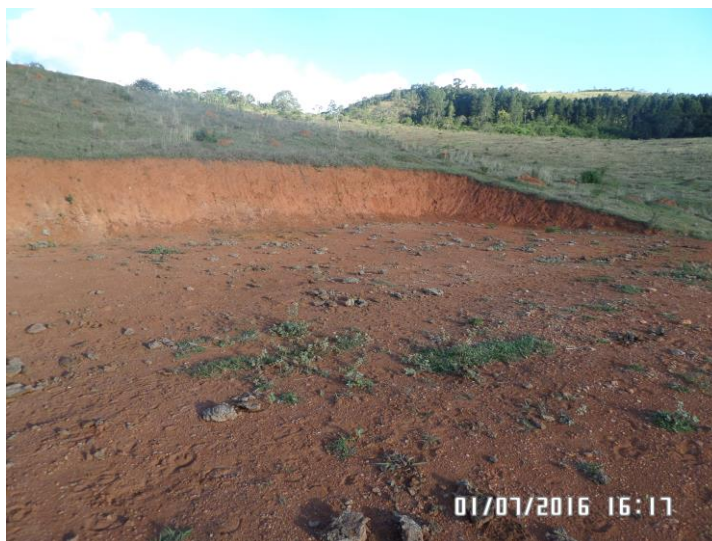
Figura 6.35 – Área de plantio – terraplanagem
