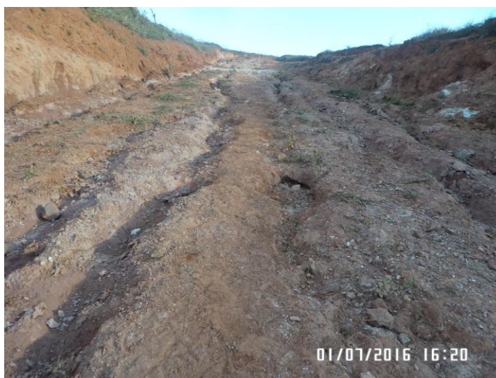
Figura 6.27 – Estrada interna – implantação de barragens galgáveis
