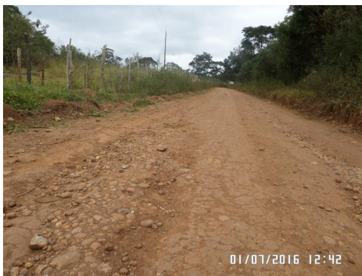
Figura 6.8 – Estrada vicinal na área da bacia do Córrego do Andaime
