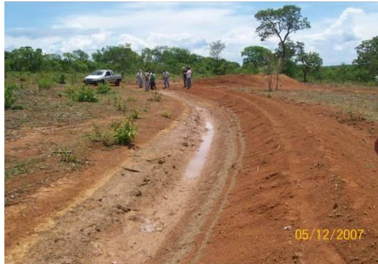
Figura 14: Exemplo de terraço executado
