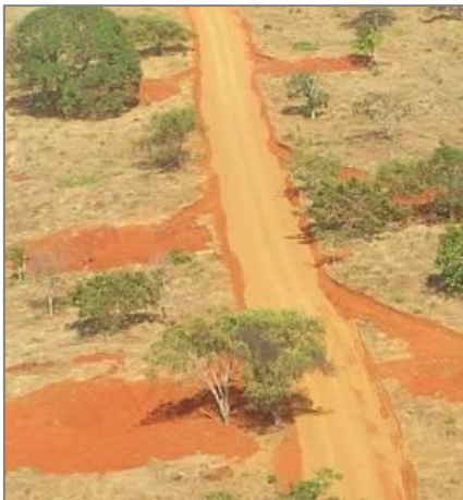
Figuras 8, 9, 10 e 11: Exemplos de Barragem Tipo 1 – Lombada, bigode e barragem
