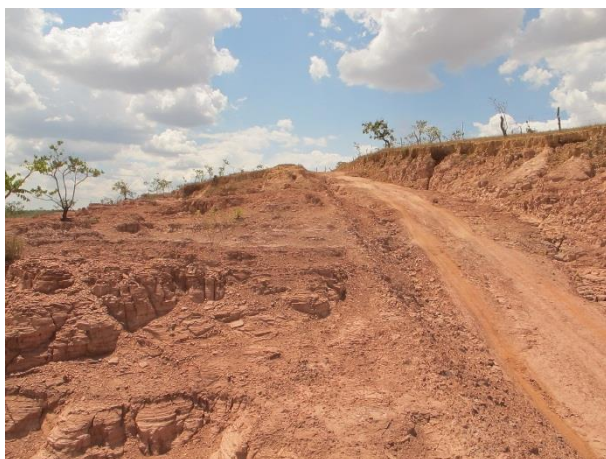
Foto 5: Vista de jusante para montante da estrada com a presença de focos erosivos. (Coord. UTM 520578 / 7954820)
