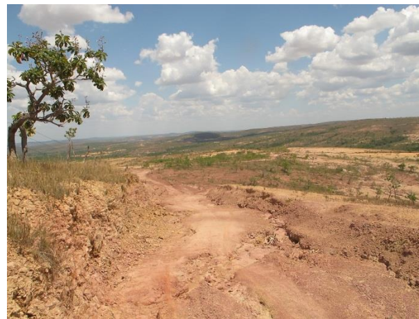
Foto 6: Vista de montante para jusante estrada com a presença de focos erosivos. (Coord. UTM 520548 / 7954870)
