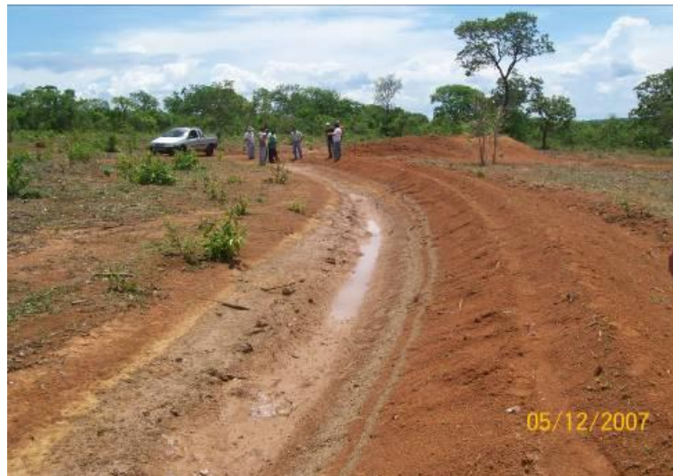
Figura 14: Exemplo de terraço executado
