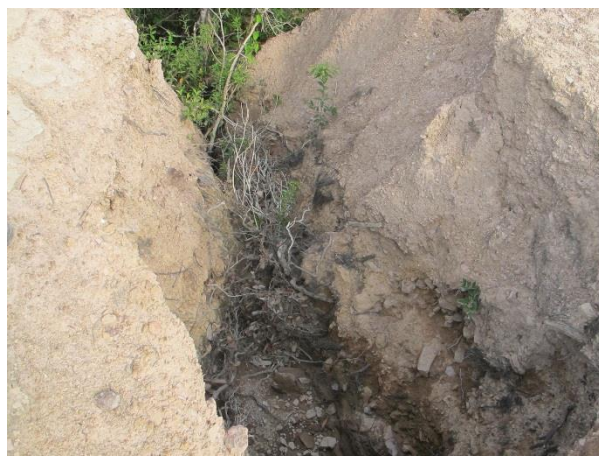
Foto 20: Detalhe do ponto de rompimento da barragem. (Coord. UTM 515519 / 7953903)
