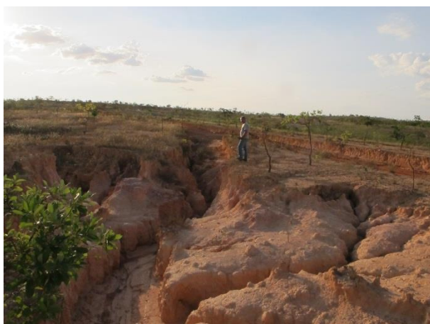
Foto 27: Vista geral das ravinas. (Coord. UTM 522010 / 7951768)
