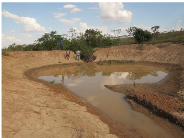
Foto 19: Vista da barragem rompida à montante da nascente. (Coord. UTM 515519 / 7953903)
