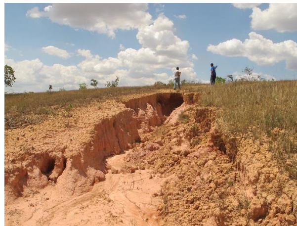
Foto 2: Detalhe do foco erosivo de jusante para montante. (Coord. UTM 520554 / 7954905)
