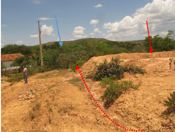
Foto 11: Linha tracejada vermelha indica o bigode existente sem conexão com a barraginha (seta vermelha) e seta azul indicando localização do rio Capivara. (Coord. UTM 522790 / 7951546)
