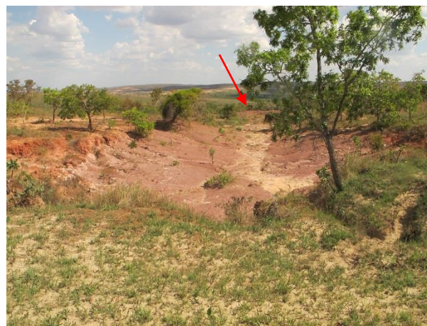
Foto 14: Vista da área degradada e ao fundo seta vermelha indicando o local do Dique existente. (Coord. UTM 517199 / 7955511)
