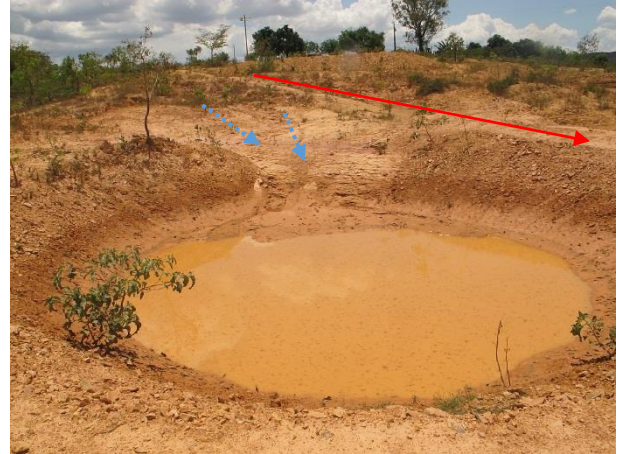
Foto 12: Vista da barraginha recebendo a contribuição parcial da encosta, sem captar as águas de enxurrada da estrada. (Coord. UTM 522790 / 7951546)
