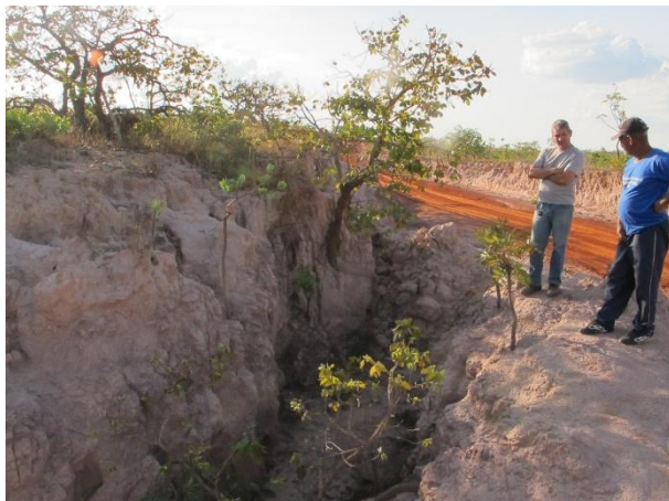
Foto 25: Um dos pontos das erosões (Coord. UTM 521900 / 7951805)
