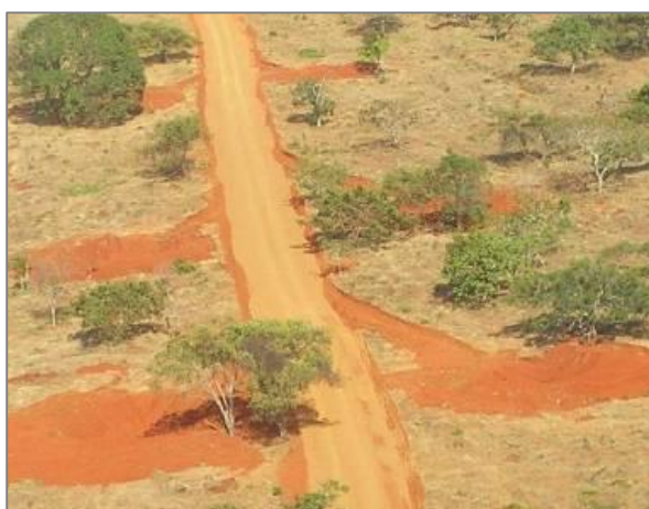
Figuras 8, 9, 10 e 11: Exemplos de Barraginha Tipo 1 – Lombada, bigode e barraginha
