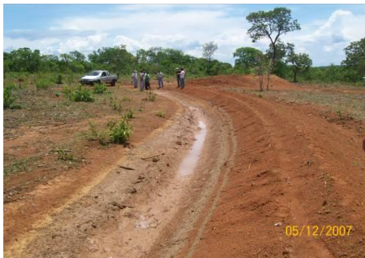
Figura 14: Exemplo de terraço executado
