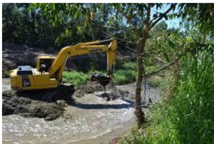
Figura 18: Remoção de sedimentos e macrófitas
