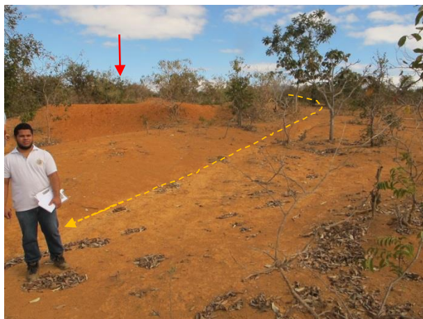
Foto 9: Vista de jusante para montante da barragem da foto 07 e a representação do canal preferencial das águas pluviais (Coord. UTM 552745 / 7930851).
