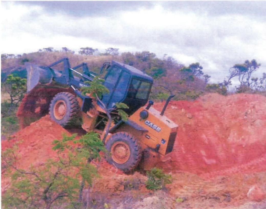
Foto 1: Construção de barraginhas para recuperação de voçorocas no Projeto de Recuperação Hidroambiental da Bacia do Rio Taquaraçu – Ato Convocatório 004/2013.
