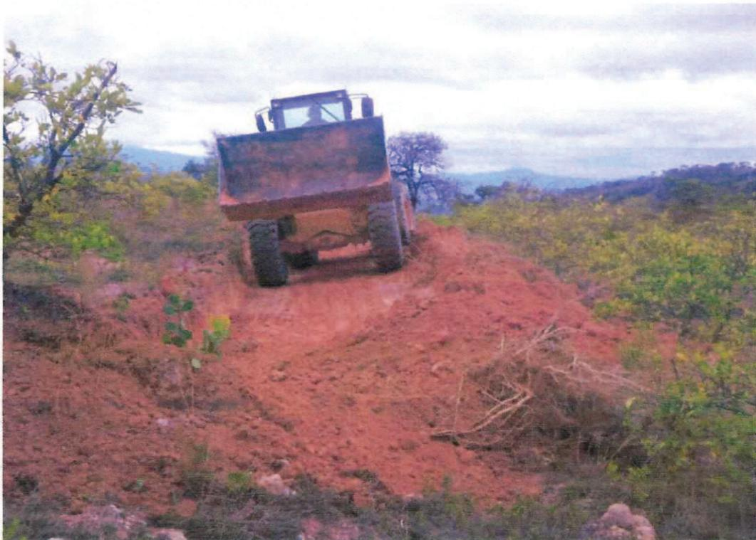
Foto 2: Construção de cordões de contorno (terraceamento) para recuperação de voçorocas no Projeto de Recuperação Hidroambiental da Bacia do Rio Taquaraçu – Ato Convocatório 004/2013.
