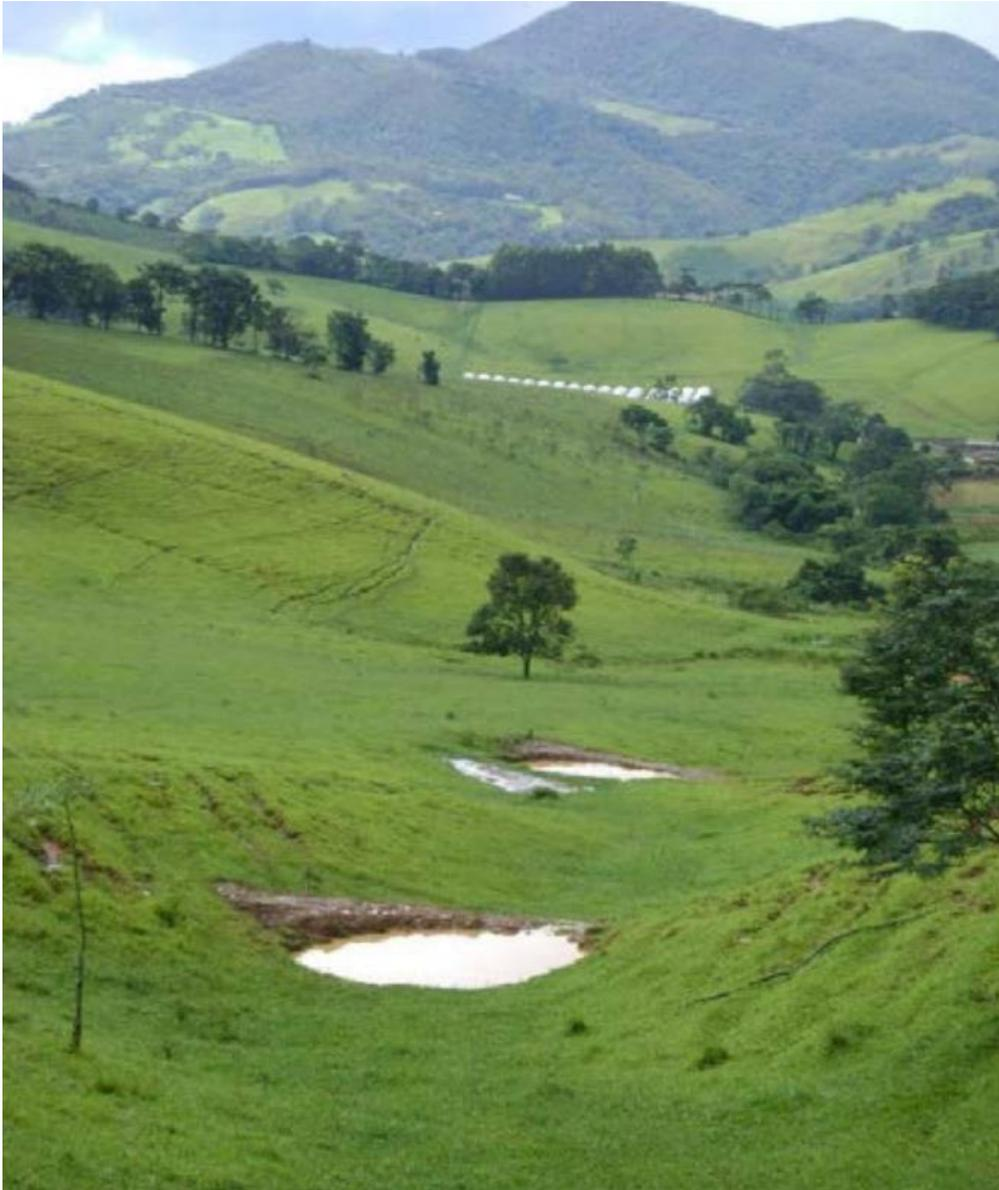
Figura 13: Barraginha construída em área de recarga de nascentes
