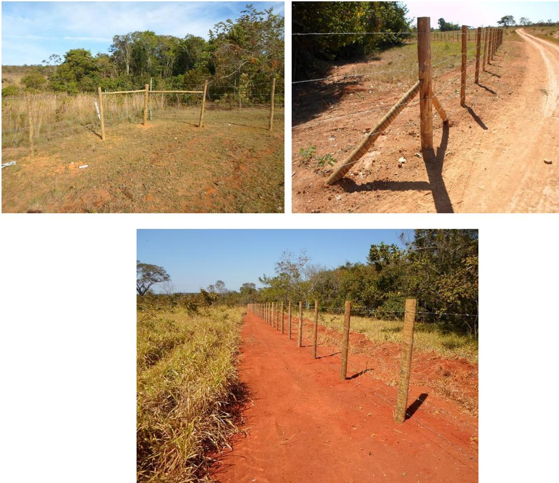
Figura 25: Cercas construídas em projetos hidroambientais na Bacia do Rio São Francisco
