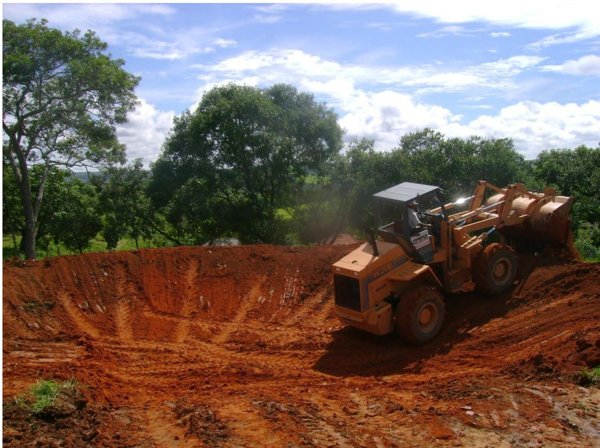
Figura 15: Pá-carregadeira durante a construção de uma barraginha
