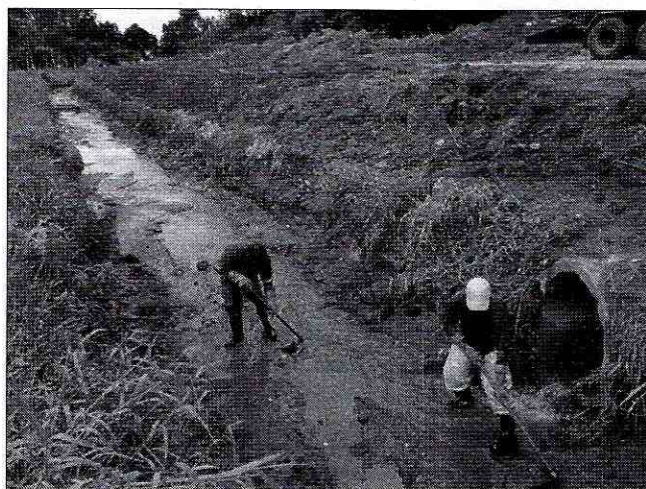
Figura 10 - Limpeza e desassoreamento de curso d'água.
