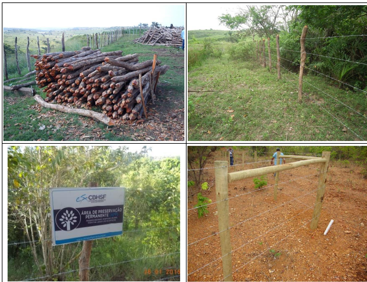
Figura 4.2 – Fotografias de cercamento executado em projeto no Baixo São Francisco.
