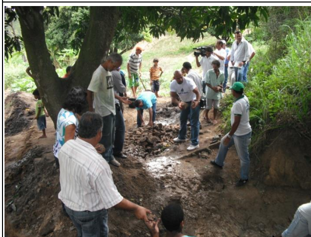
Figura 4.13 – Colocação das pedras.
