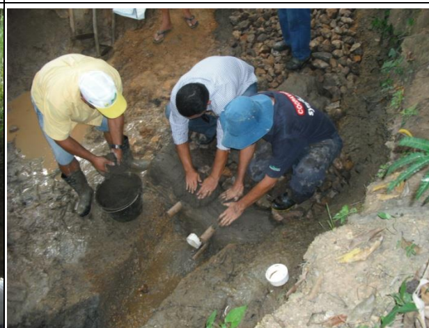
Figura 4.14 – Assentamento dos tubos.
