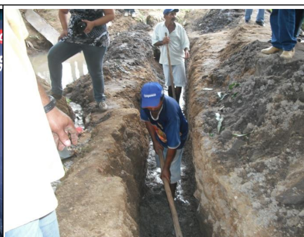
Figura 4.10 – Limpeza da nascente.
