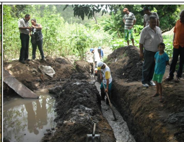
Figura 4.12 – Limpeza da nascente.
