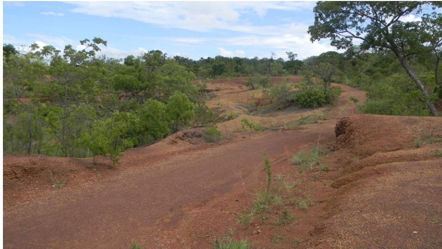
Figura 6.5 – Exemplo de estrada vicinal sem manutenção adequada
