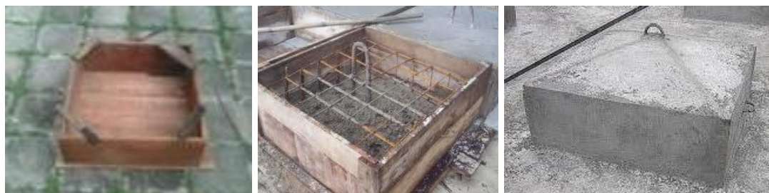
Figura 11.2 - Ilustração da execução de uma poita.
