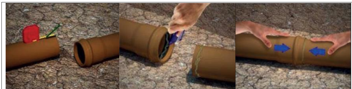
Figura 11.9 - Montagem dos tubos de PVC JE PBA.
