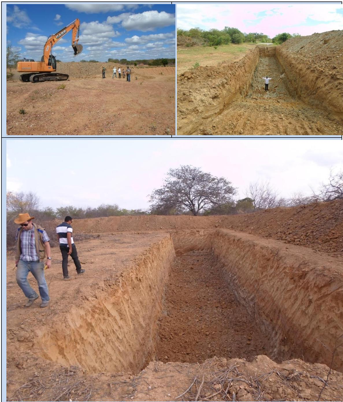
**Figura 7.8 - Barreiros Trincheira construídos no projeto hidroambiental de Curaçá-BA.**
