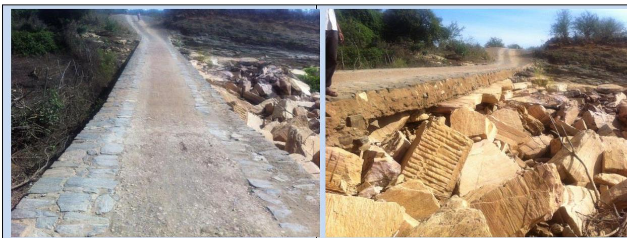
**Figura 7.6 - Passagens Molhadas construídas na bacia do Mocambo.**
