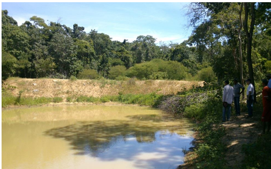
Figura 6.7 - Barreiro rudimentar construído na calha do riacho Caracol na Comunidade José Rosa, em Sítio do Mato.
