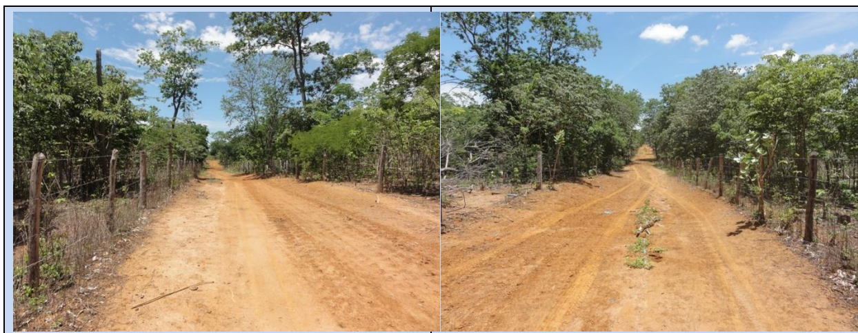
Figura 6.4 - Fotografias da Estrada Rural 02.
