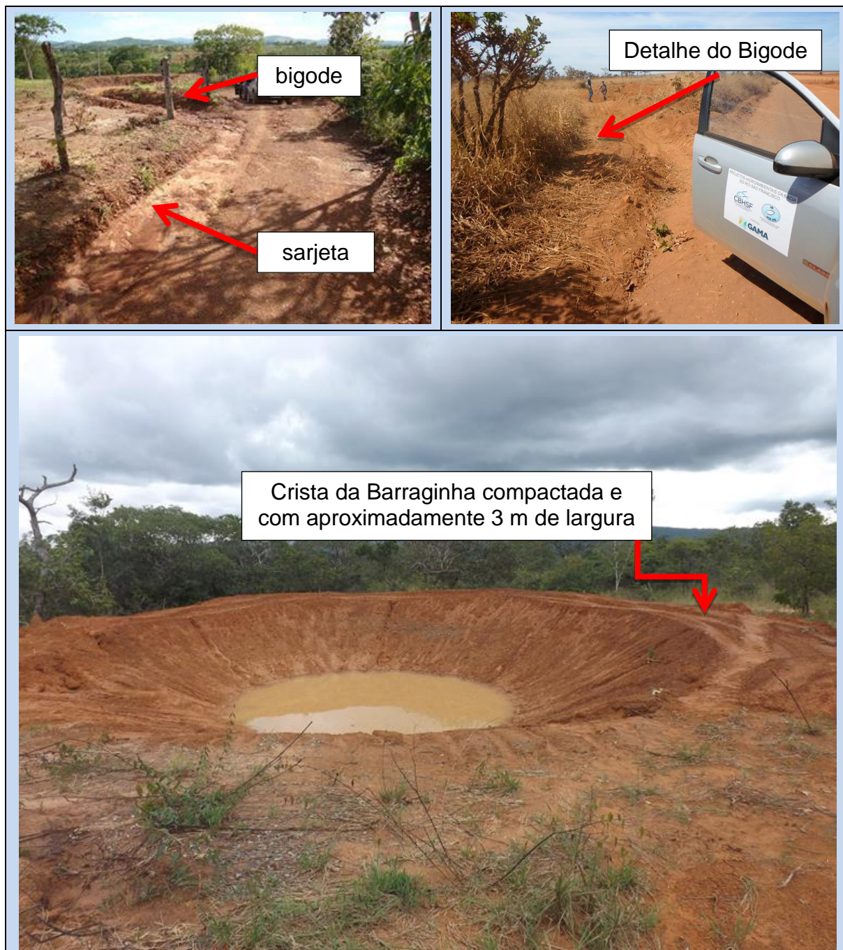
Figura 7.3 - Estradas rurais adequadas em projetos hidroambientais da bacia do rio São Francisco.
