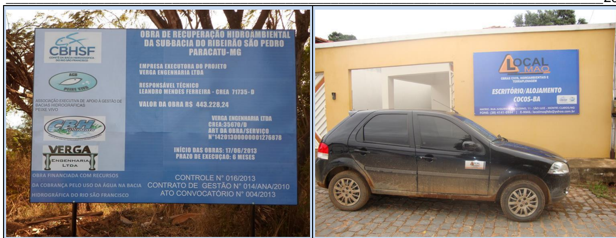
Figura 7.1 - Placa da Obra e Canteiro/Escritório de obras hidroambientais contratadas pela AGB Peixe Vivo.
