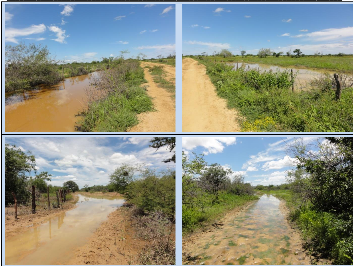
Figura 6.2 - Estrada Rural a ser adequada.
