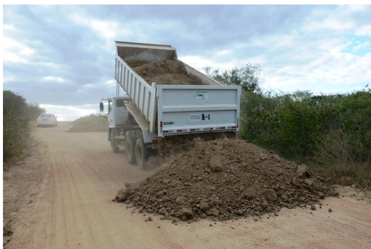
Figura 7.4 - Descarga de cascalho em pilhas por caminhão basculante.
