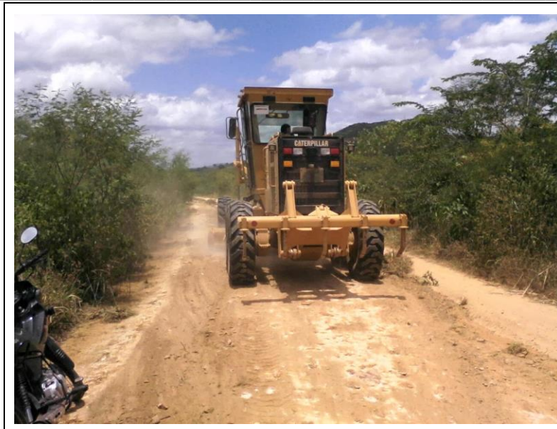
Figura 7.2 - Trabalho de regularização de estrada vicinal por motoniveladora com vista frontal e traseira do serviço.
