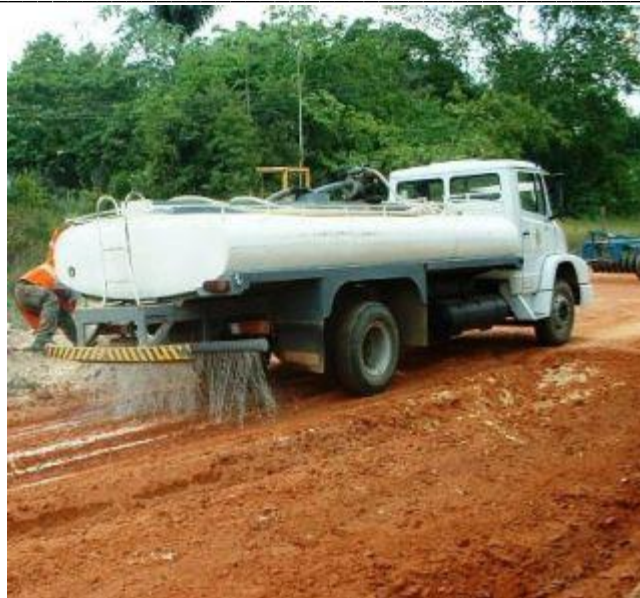
Figura 7.8 - Caminhão pipa molhando material espalhado em pista de rolamento.
