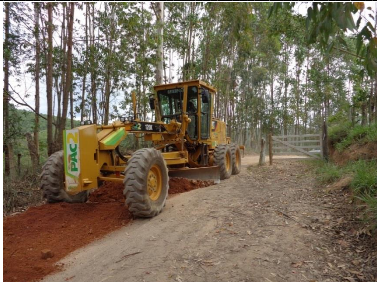
Figura 7.5 - Motoniveladora realiza o espalhamento de cascalho recém descarregado sobre a plataforma de uma estrada vicinal.
