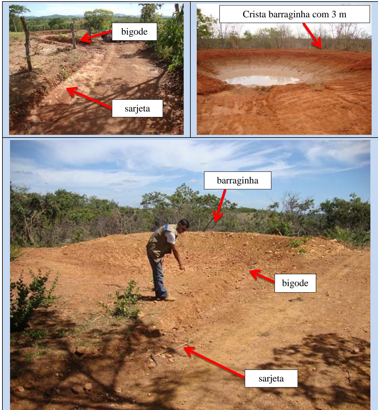
Figura 0.23 - Estradas rurais adequadas em obras hidroambientais da bacia do rio São Francisco.
