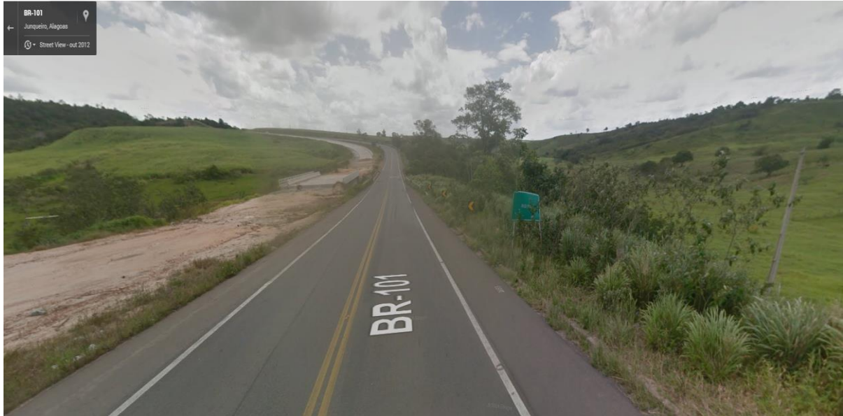
Figura 5.7 - Vista da ponte sobre o rio Piauí na rodovia BR101, entre Junqueiro e São Sebastião.
