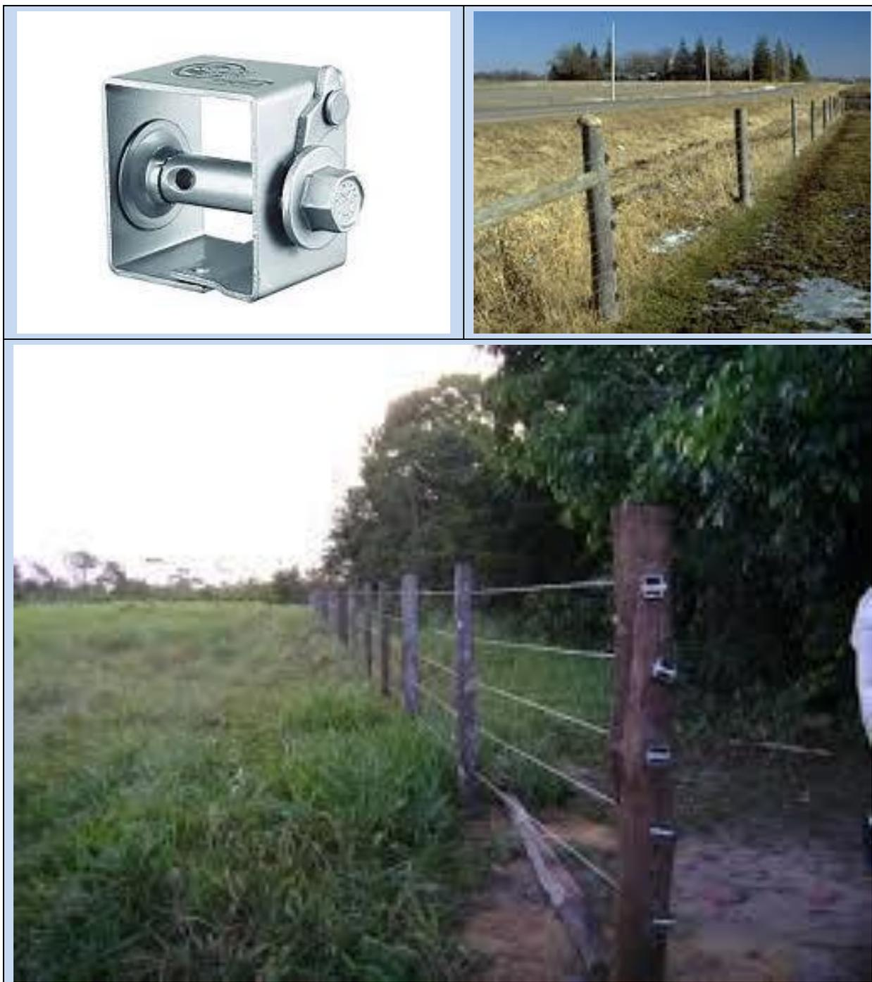
**Figura 0.34 - Cercas construídas com arame liso.**
