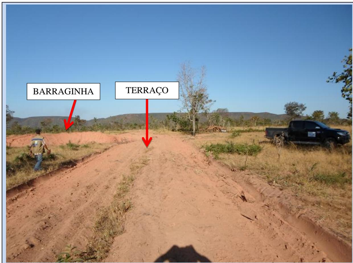
**Figura 0.38 - Terraço com barraginha em obras hidroambientais da BHSF.**
