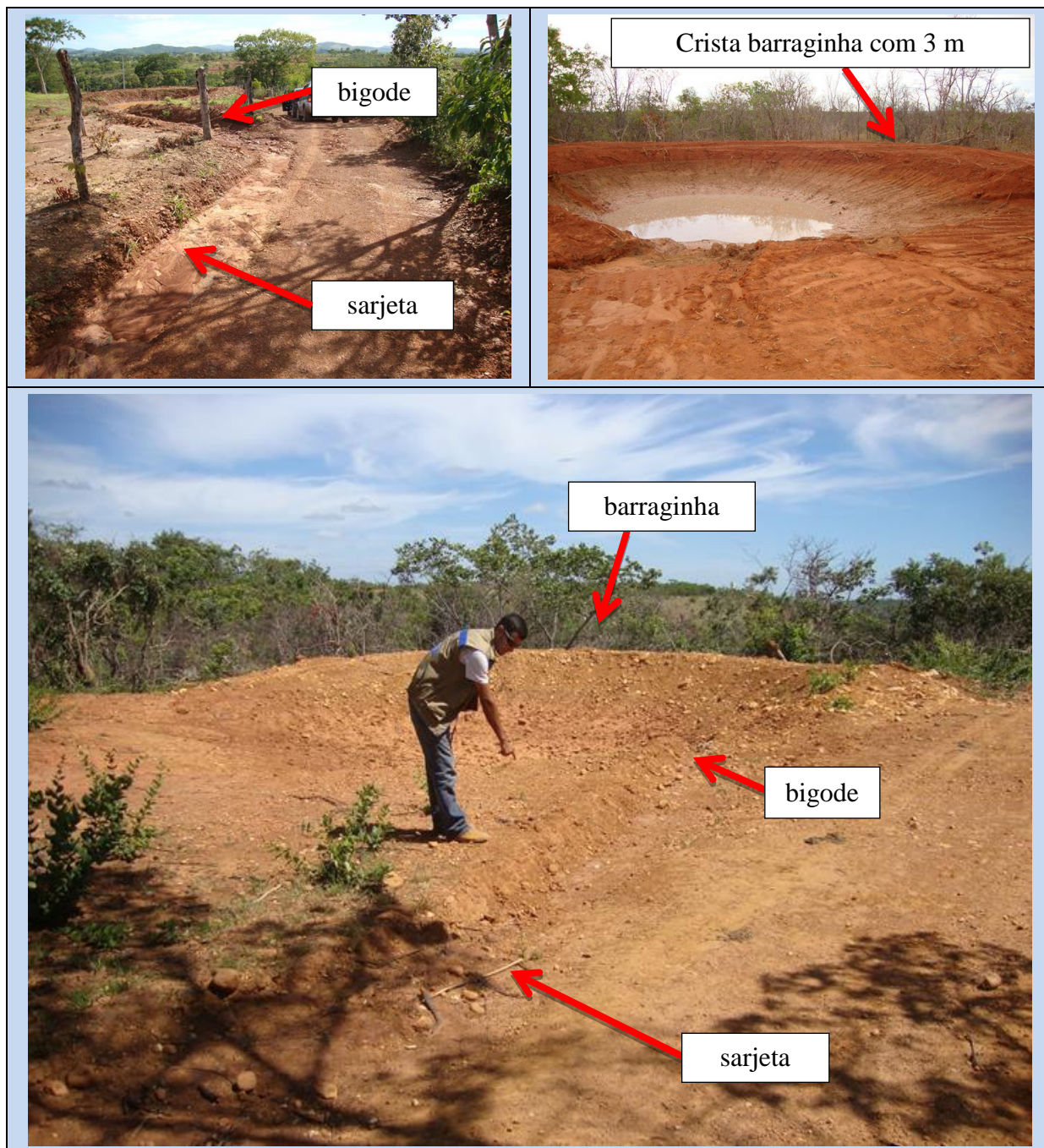
Figura 0.22 - Estradas rurais adequadas em projetos hidroambientais da bacia do rio São Francisco.
