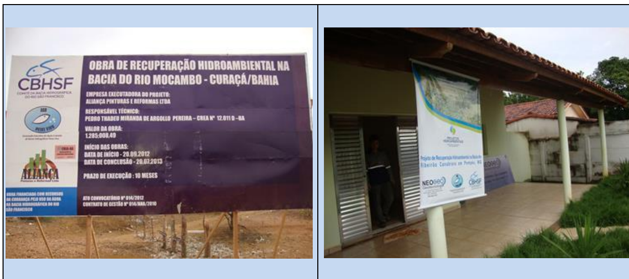
Figura 0.18 - Placa da Obra e Canteiro/Escritório de projetos hidroambientais contratados pela AGB Peixe Vivo.
