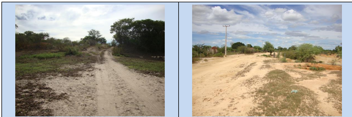
Figura 0.9 - Fotos das Estradas Rurais que serão adequadas.
