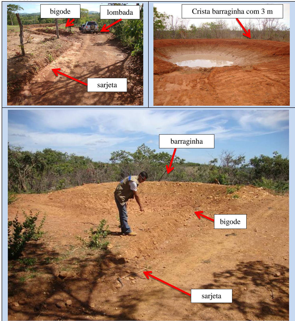
Figura 7.5 - Dispositivos de drenagem das estradas rurais para as barraginhas.
