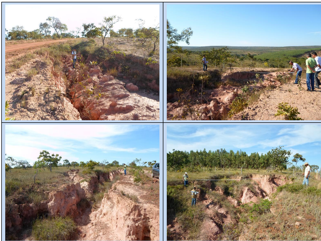
Figura 6.27 - Fotos de voçorocas onde serão construídas as paliçadas.
